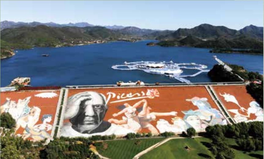
▲ Barrage du lac Jinhai
