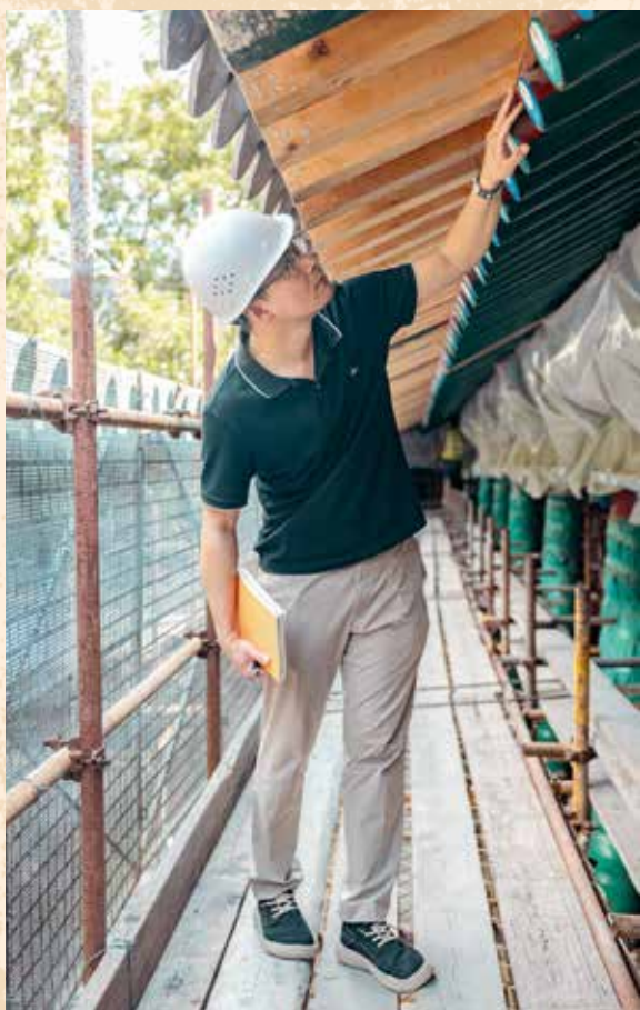
▲ Zhang Jiajia vérifie depuis l'échafaudage la structure restaurée des 76 Services du Jugement du Temple Dongyuemiao
