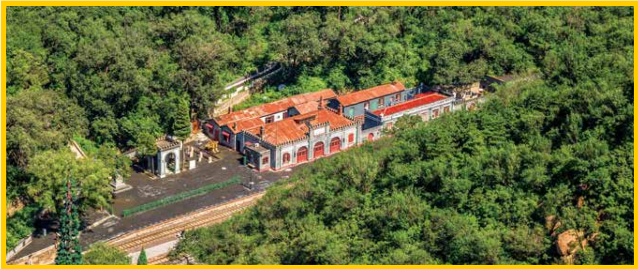
▼ La gare de Qinglongqiao sur la ligne Pékin-Zhangjiakou conserve son aspect centenaire
