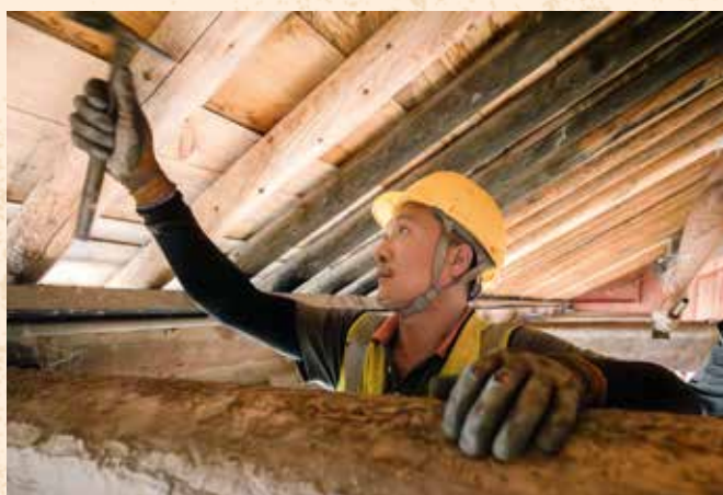
▲ Ouvriers restaurant la toiture de la Salle des 76 Services du Jugement du Temple Dongyuemiao
