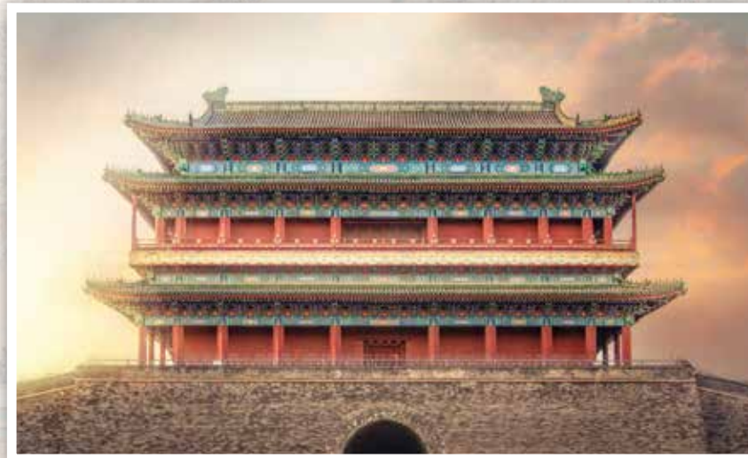
▲ Tour de Zhengyangmen, réaménagée par Zhu Qiqian en 1915 pour fluidifier la circulation urbaine ancienne
